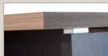
Distanciadores entre tampos e laterais em PS (Poliestireno) com acabamento cromado.
